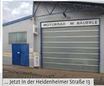
... Jetzt in der Heidenheimer Straße 13
